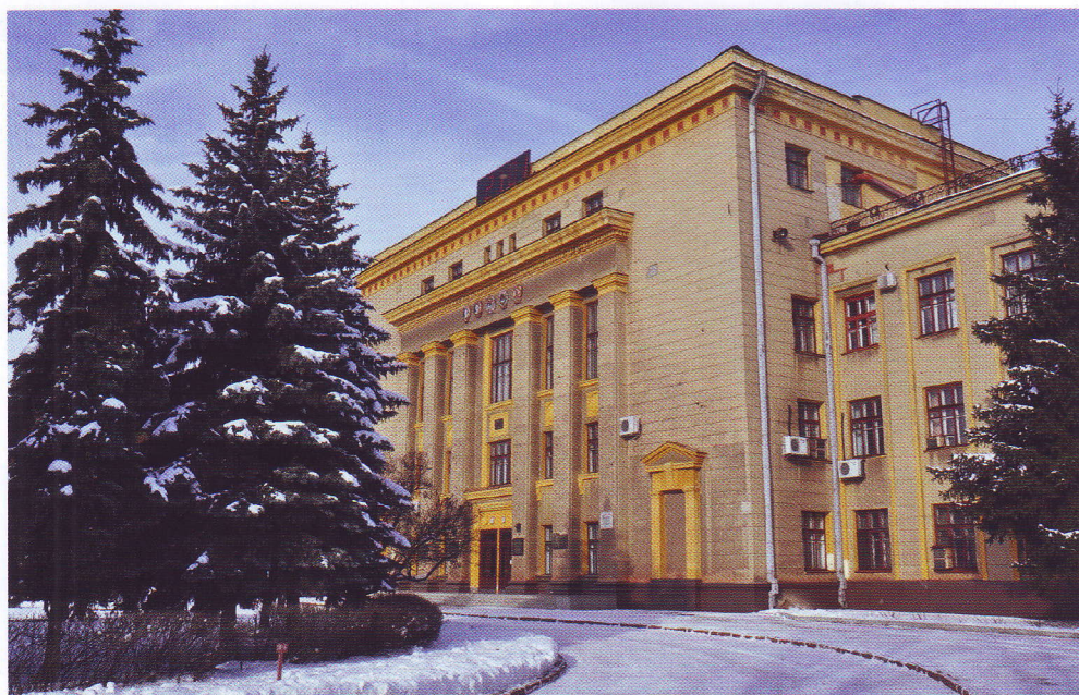
Административный корпус Харьковского тракторостроительного завода.
